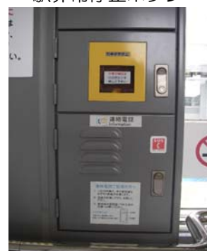
駅非常停止ボタン
