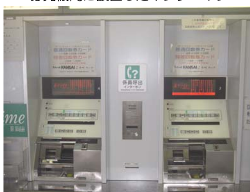
券売機間に設置したインターホン
