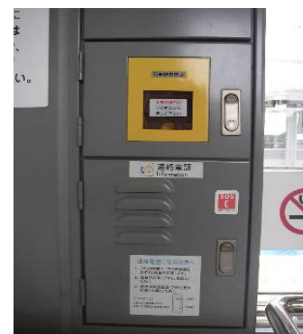
【駅非常停止ボタン】
