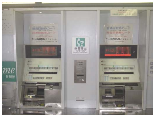
【券売機間に設置したインターホン】
