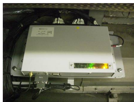
【運転状況記録装置】
