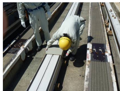
【軌道ループの点検】
