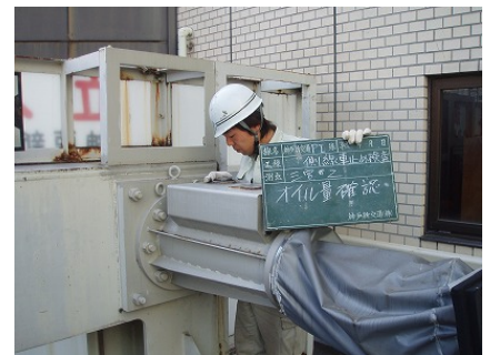
【車止め検査（緩衝材部オイル量確認状況）】
