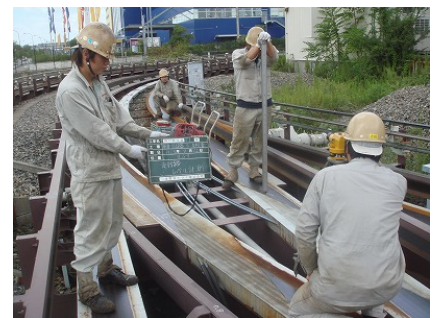
【車庫分岐器検査（走行路の水準計測状況）】
