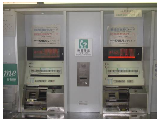
【券売機間に設置したインターホン】
