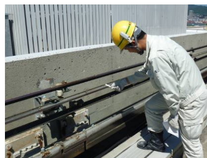
【電車線の点検】
