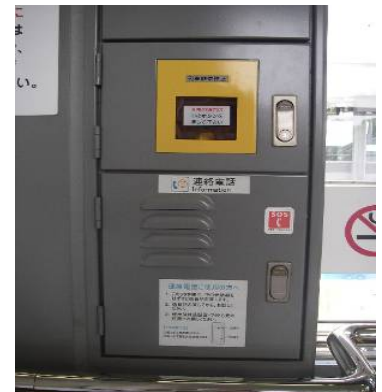
【駅非常停止ボタン】
