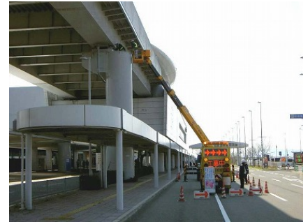
【高所作業車を使用による近接目視状況】
