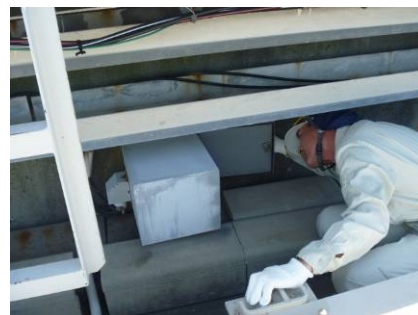
【整合変成器箱の点検】
