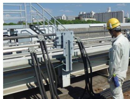
【き電ケーブルの点検】
