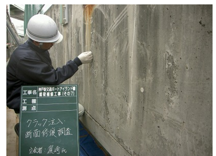
【コンクリート高欄調査状況】
