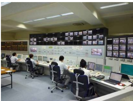
【ポートアイランド線総合司令所】
