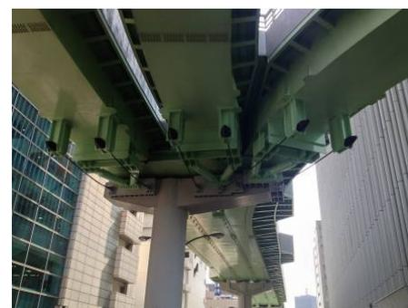
耐震補強（落橋防止）後の桁
