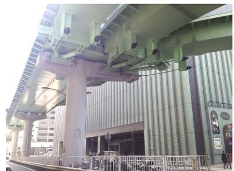
耐震補強（落橋防止）後の桁
