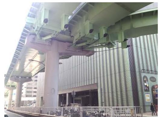
耐震補強(落橋防止)後の桁
