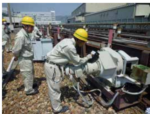
電気課 転てつ機定期検査
