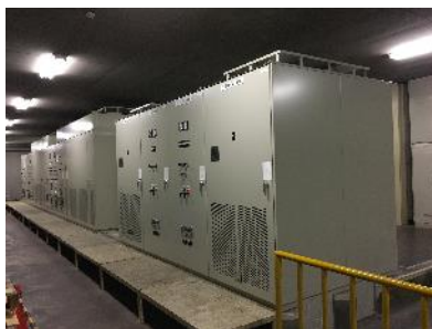
【ポートアイランド線 ポートターミナル変電所更新】
