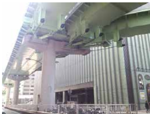
耐震補強(落橋防止)後の桁
