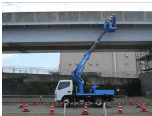
施設課 高所作業車を用いた高欄点検
