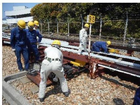
電気課 転てつ機定期検査訓練
