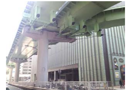
耐震補強(落橋防止)後の桁
