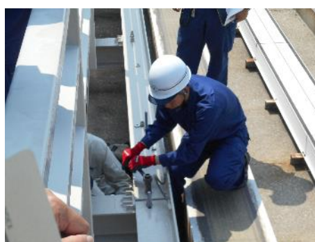
施設課 案内軌条締結ボルト交換補修訓練
