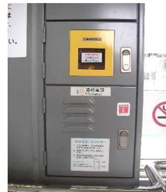
駅非常停止ボタン
