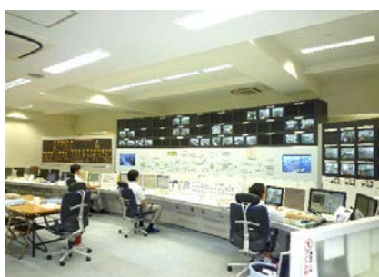
ポートアイランド線総合司令所
