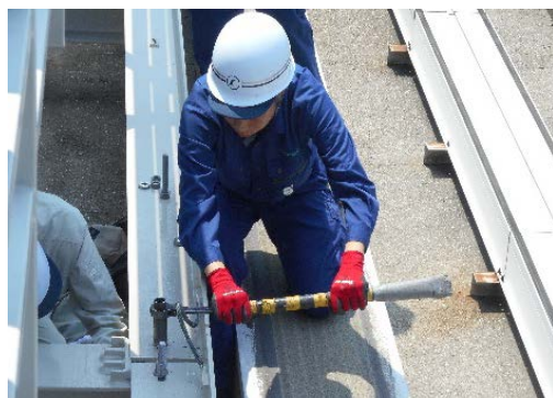
施設課 案内軌条締結ボルト交換補修訓練
