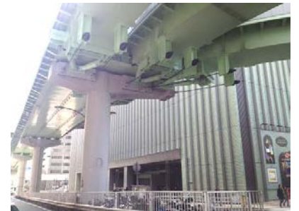
耐震補強(落橋防止)後の桁
