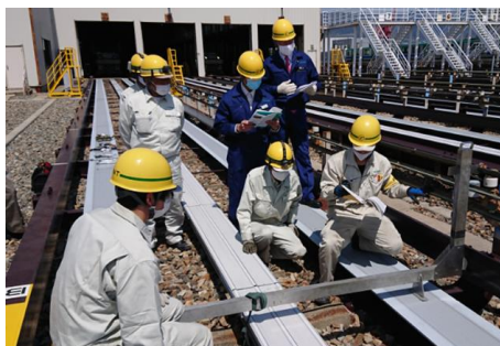
電気課 トrolley線・架台及び支持碍子交換訓練
