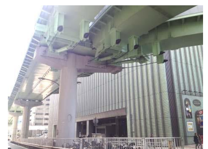
耐震補強(落橋防止)後の桁
