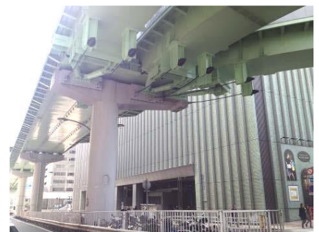
耐震補強（落橋防止）後の桁
