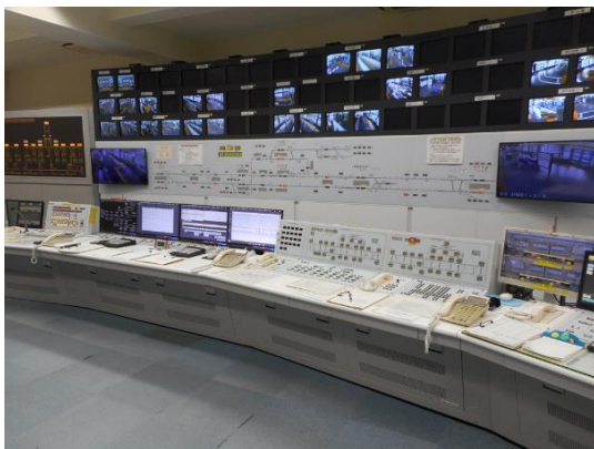
ポートアイランド線総合司令所
