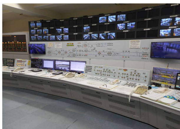
ポートアイランド線総合司令所
