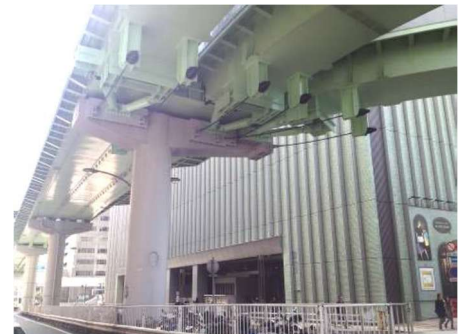
耐震補強(落橋防止)後の桁
