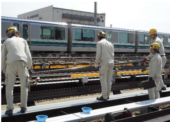
電気課 トリー線・架台及び支持碍子交換訓練
