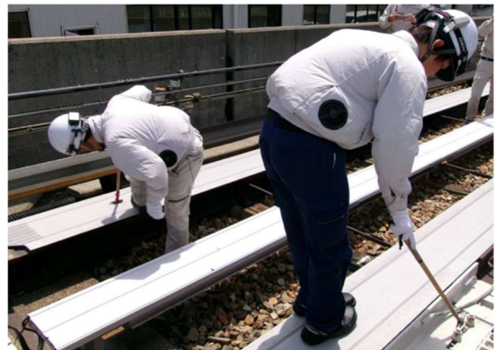
施設課 案内軌条異音補修訓練
